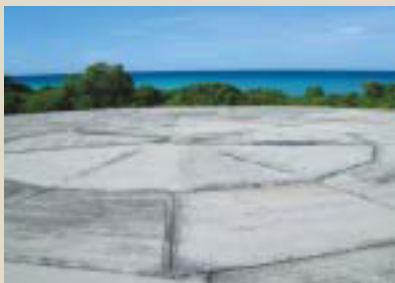
放射能汚染物をコンクリートで格納したドーム。 エニウェトク環礁のルニット島。 提供:竹峰誠一郎
